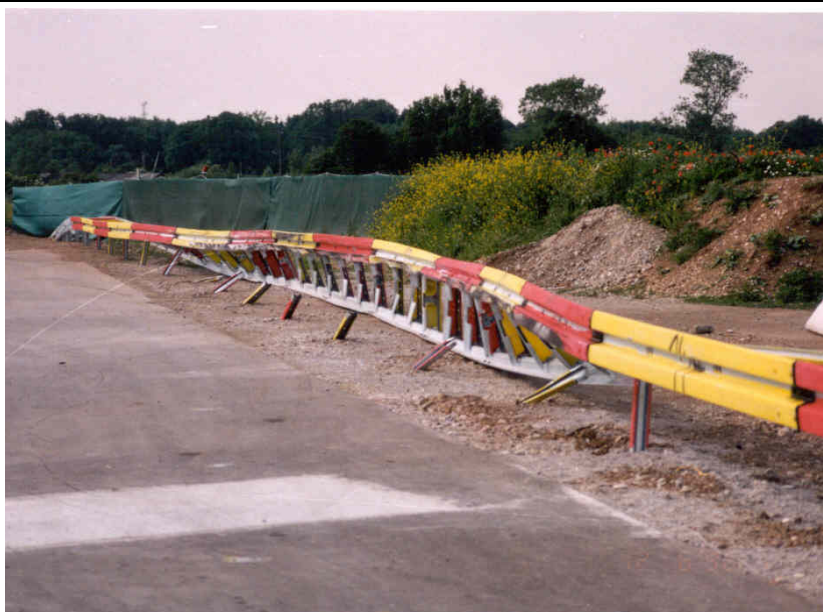
Bild 9: Schutzeinrichtung nach der Prüfung
