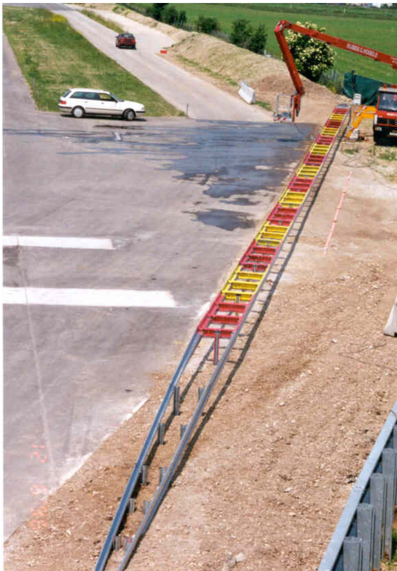
Bild 1: Schutzeinrichtung Gesamtansicht mit An- fangs- und Endabsenkung
