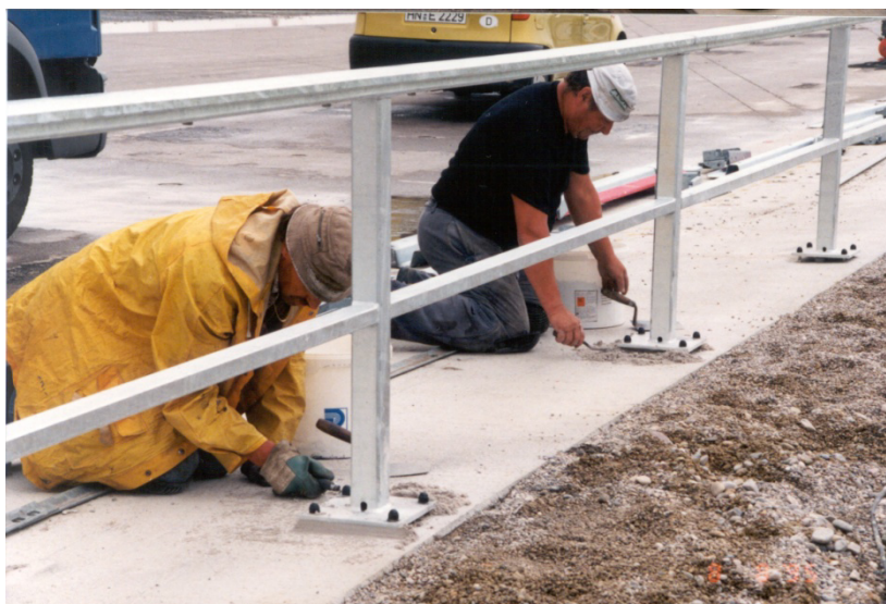
Bild 2: Detail Geländer: Verankerung
