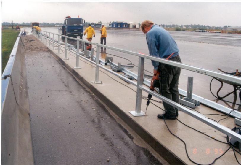
Bild 1: Montage des Geländers auf der Brückenkappe
