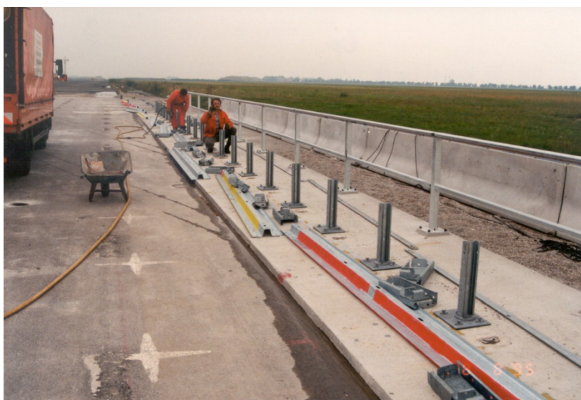
Bild 3: Montage der Schutzeinrich- tung auf der Brückenkappe
