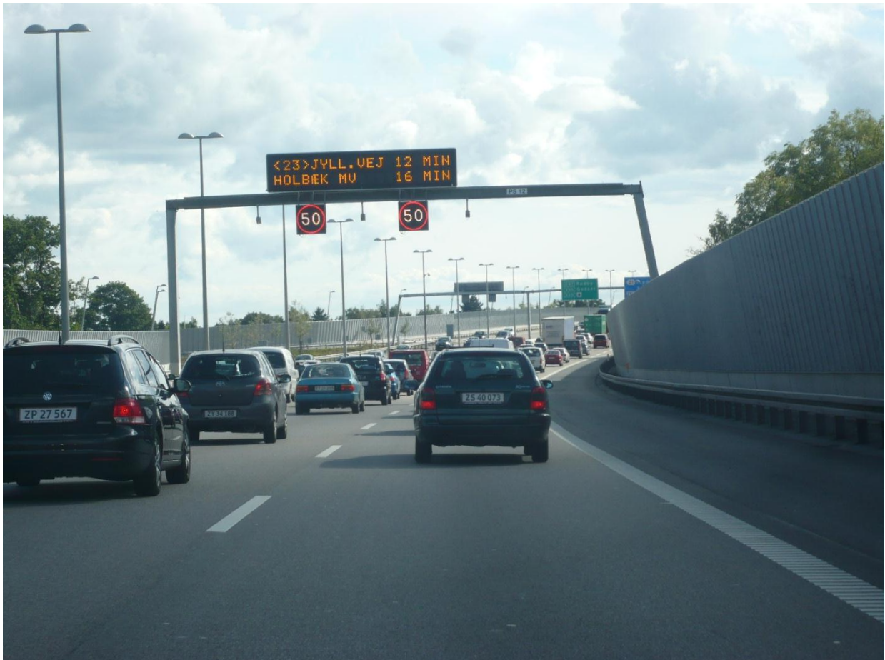
Abbildung 20: Geschwindigkeitskontrolle bei der Wechselverkehrszeichen auf Autobahnring 3 um Kopenhagen verwendet werden
