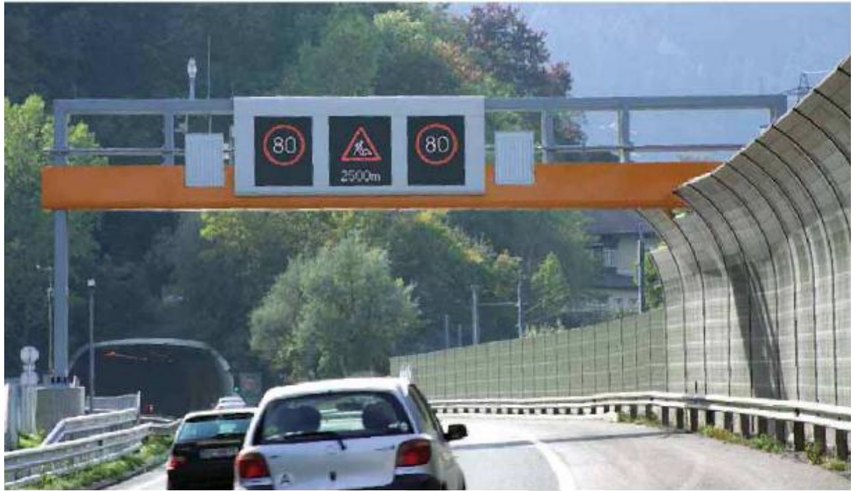
Abbildung 22: Beispiel für die Dynamischen Streckenbeeinflussungs-Verkehrszeichen an der den Autobahnen A12/A13 in Tirol
