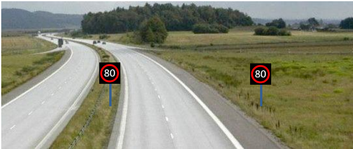
Abbildung 11: An der Seite montierte VSL Verkehrszeichen auf der Autobahn
