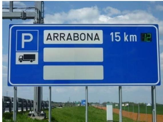
Abbildung 15: WVZ (Wechselverkehrszeichen)
